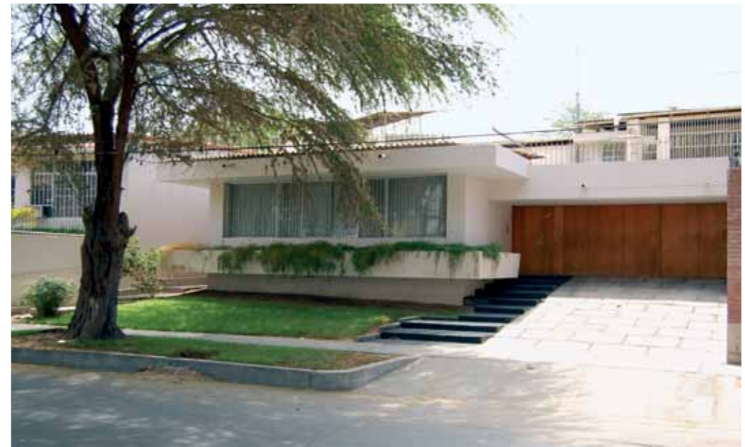
Exterior de la vivienda Woodman.
