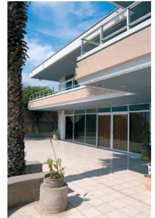
Vista de la terraza hacia el comedor y la cocina.
