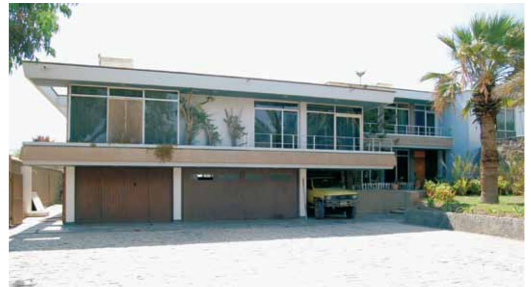
Vista de la fachada de ingreso.
