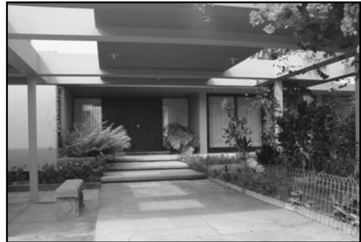
70.- Vista del ingreso principal.
