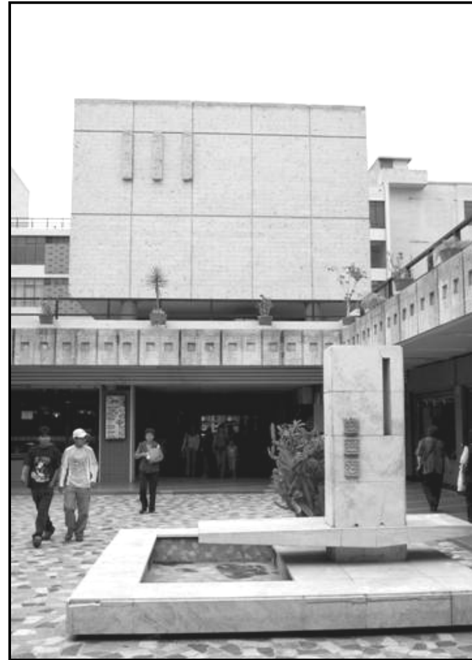
18.- Gonzalo Olivares R., Edificio Comercial GAMESA, Arequipa, 1962. (Vista Interior)
