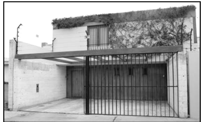
53.- Vista del ingreso principal y las cocheras.
