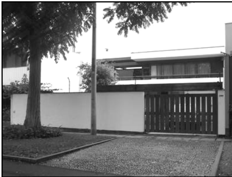
34.- Vista exterior de la vivienda Matos.
