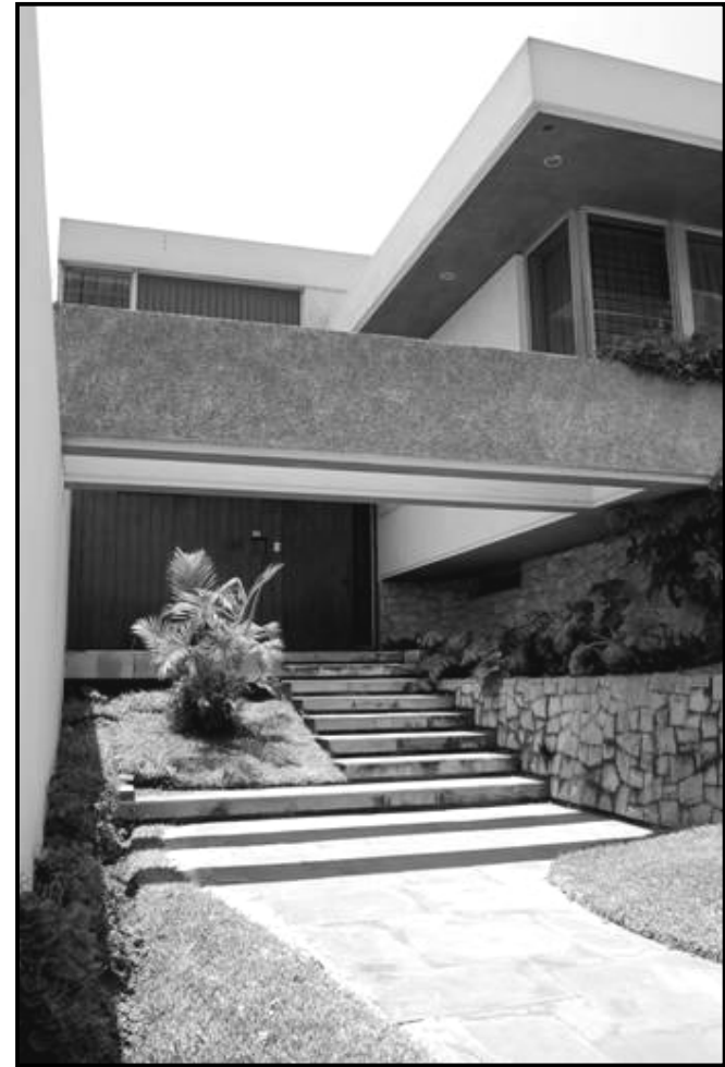
49.- Vista del ingreso principal.
