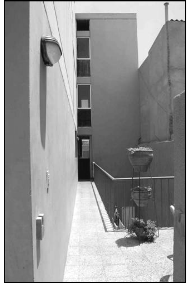
90.- Vista del área de servicio.
