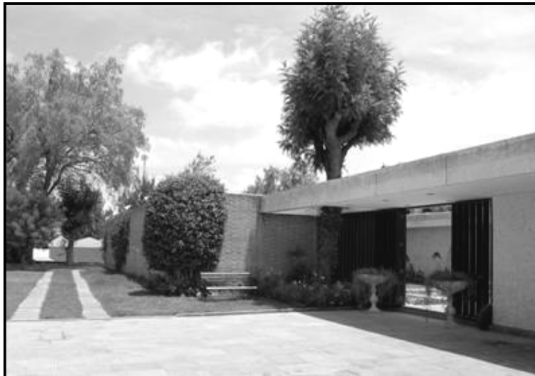
57.- Vista del acceso a la vivienda.
