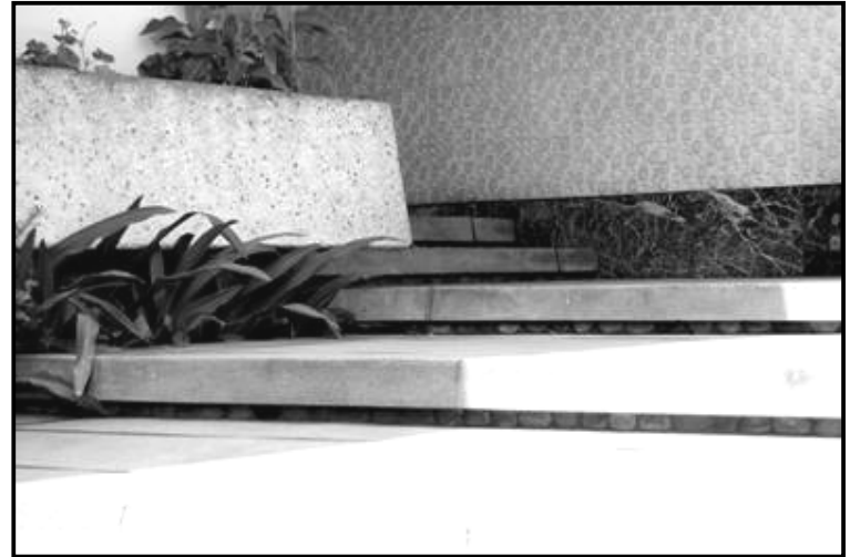
25.- Vista del detalle de los acabados del ingreso.
